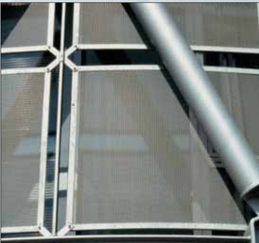
TYP 25 - DL 28 x DC 10 (10) - av 1,5 - sp 1,5 mm Stahlblech mit Polyester-Pulverbeschichtung für den Außenbereich
